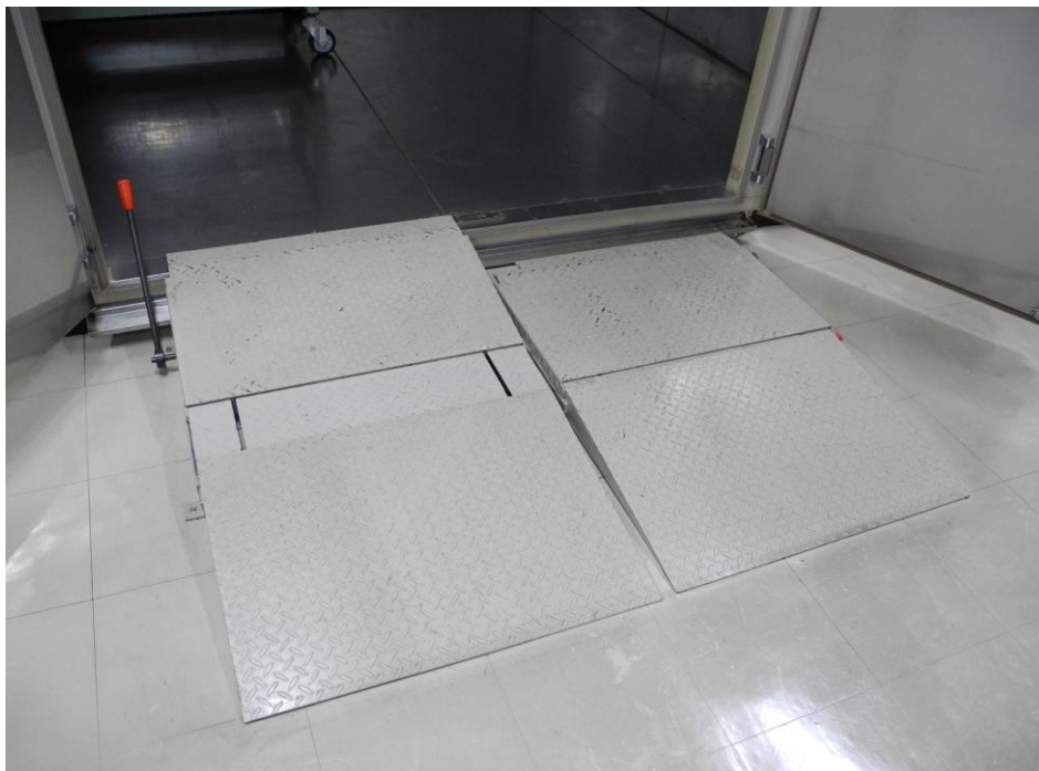
機材搬入スロープ
