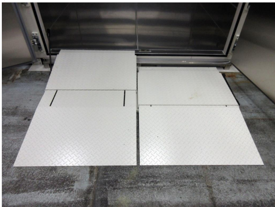
機材搬入スロープ
